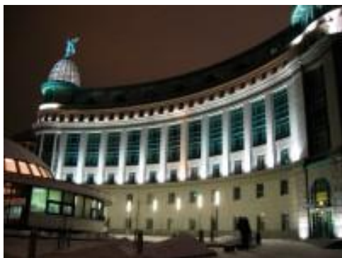
Банк Аркада, Киев (виброизоляция инженерного оборудования)
