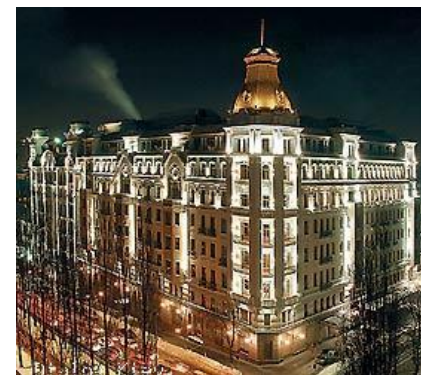
Отель Премьер Палас, Киев (звукоизоляция инженерного оборудования)
