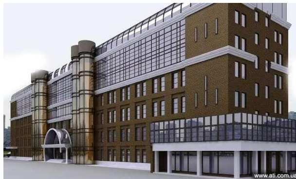
Бизнес-центр Риальто, Киев (звукоизоляция инженерного оборудования)
